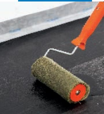
Aplicación de **Primer per Aquaflex** sobre una membrana asfáltica existente
