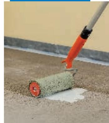
Sustrato cementicio imprimado con Mapecoat I 600 W
