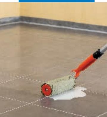
Aplicación del primario **Mapecoat I 600 W** sobre losetas adecuadamente preparadas
