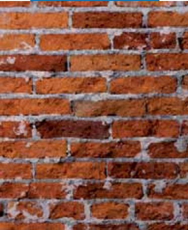
Muro de albañilería de ladrillo después de retirar el revoque degradado
